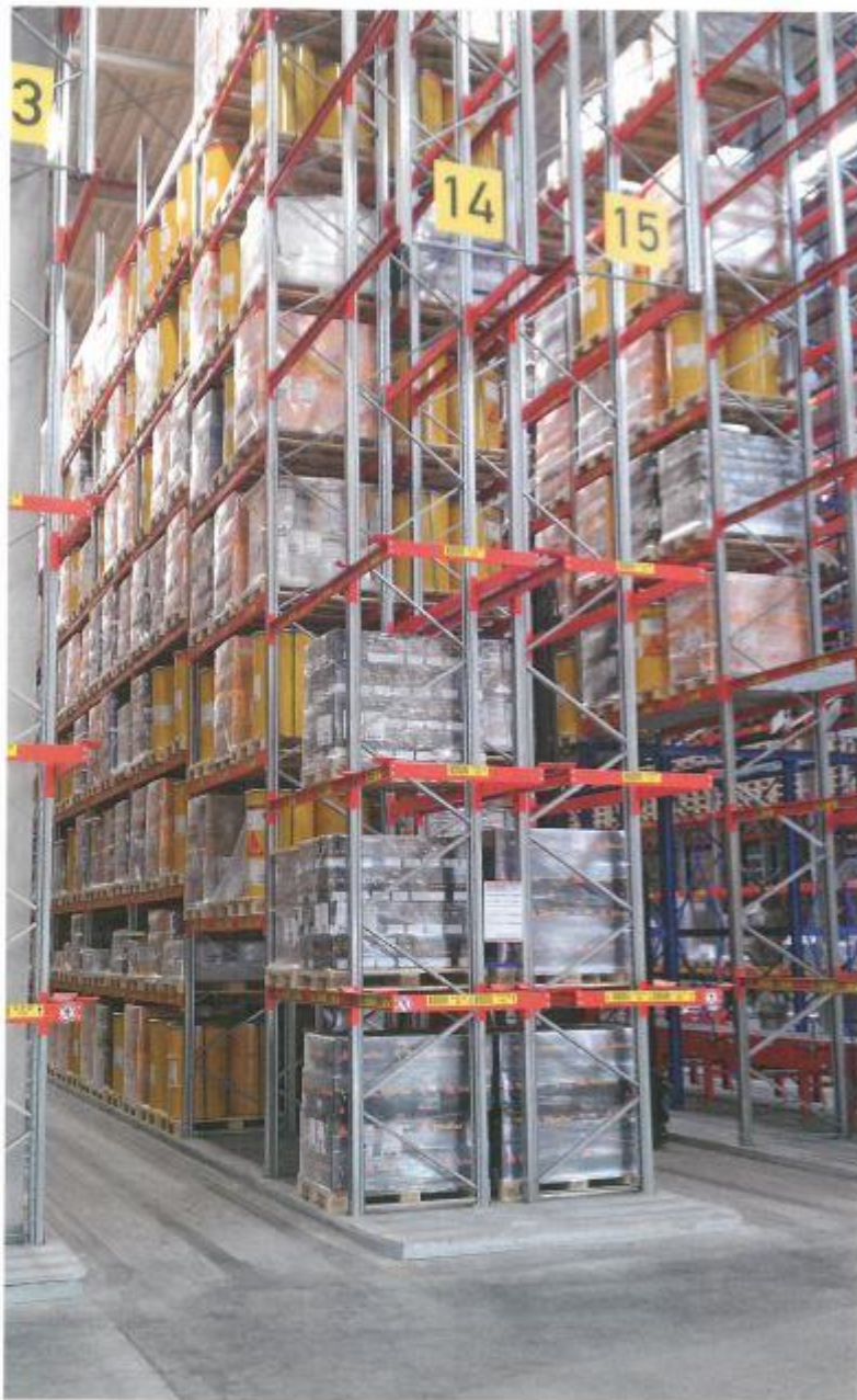
Die Regalanlage im neuen Gefahrgutlager von LSU Schäberle bietet Platz für 25.000 Paletten.
